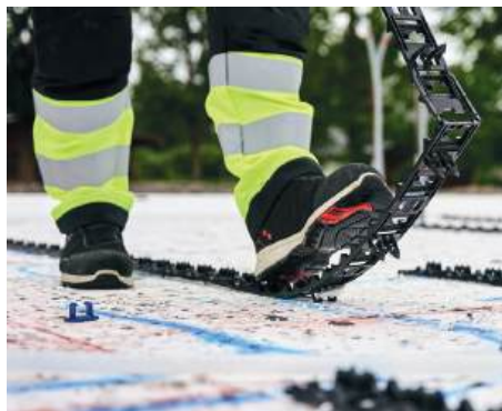
LK Golvvärmelist Combi 16/20 på EPS-isolering.
