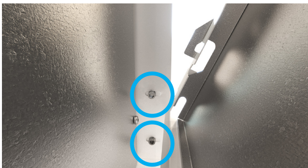
Montering av den kaklingsbara ramen.
