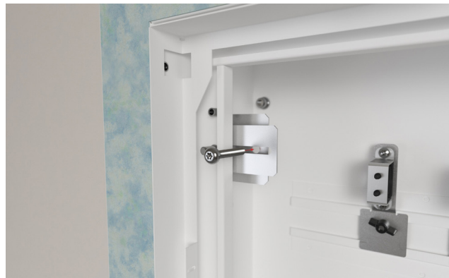
Våtzensluckan monteras i skåpet.
