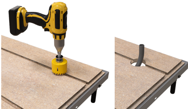
Borrat hål i Heatfloor 22. Tomröret uppdraget genom hålet.
