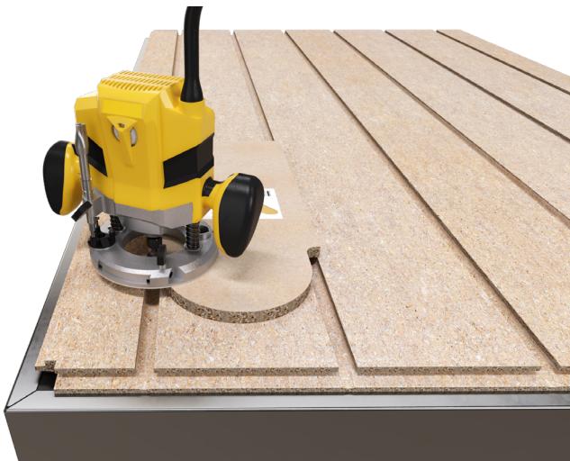
Platsfrästa vändspår måste understödjas av golvregel.
