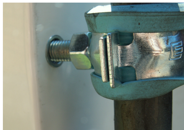
Närbild på infästning mot skåp.
