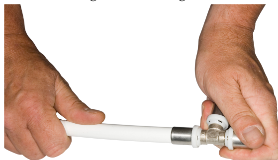
Inskjutning och vridning av det gradade röret.
