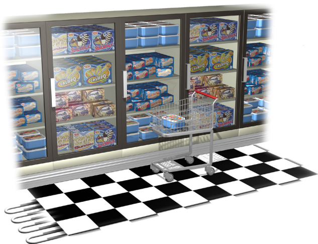
Golvvärme med spillvärme från kylanläggning.
