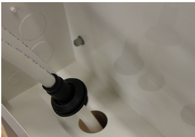
Montera rör genomförningarna
