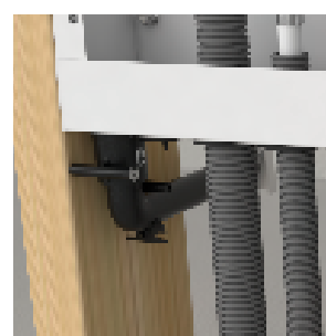
Principbild. Dränagebøj direktansluten mot skåpets utloppsstos mynnar i samma rum som skåpets serviceöppning.
