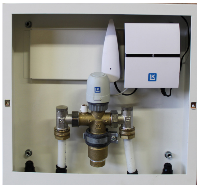
LK Minikretsventil M5 kompletterad med LK Mottagarenhet 1 ICS.2-RF. Utrustningen är monterad i LK Inbyggnadsskåp M5 VT-XL.
