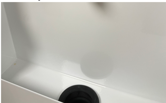
Rörgenomföringen i botten av skåpets insida.
