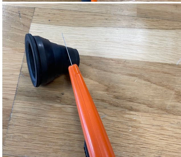
Kapning av LK Rör genomföring 20-25 LP. Anpassas till vattentutkastarens kopparrör.
