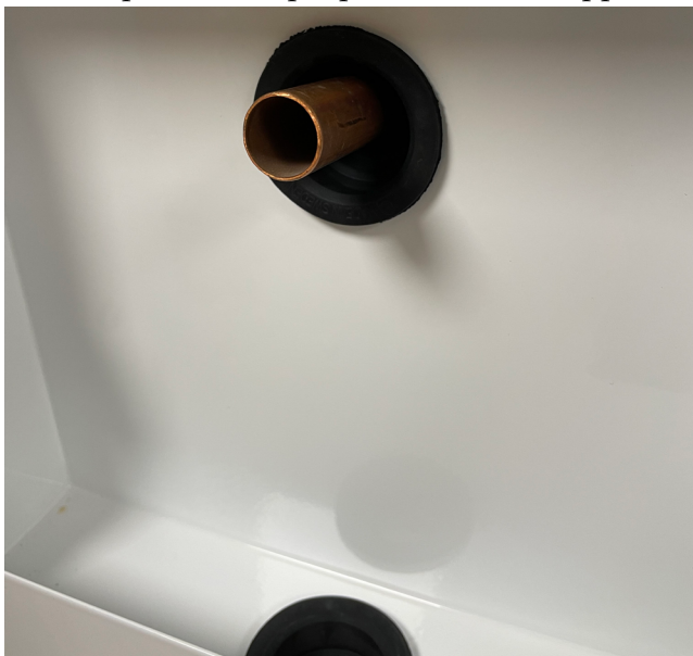
Insidan av skåpet med rörgenomföringen och kopparröret.
