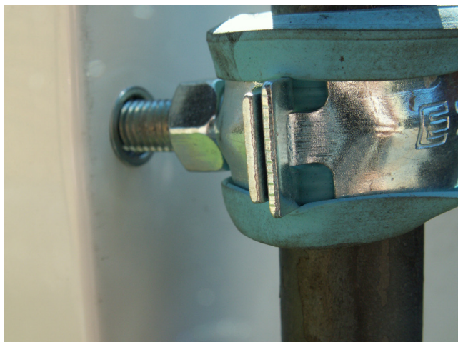
Nærbilde av festing mot skap.
