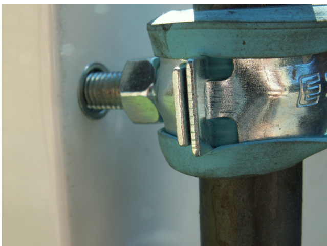
Lähikuva telineen kiinnityksestä kaappiin.
