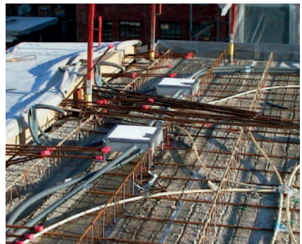
Installationsexempel med LK Kopplingslåda.
