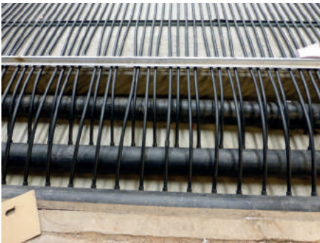
Prefabricerad PEH-fördelare.
