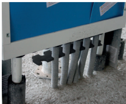
Installationsexempel med LK Fixeringsplatta RiR 25.
