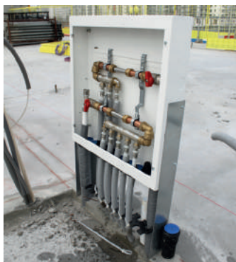
Installationsexempel med LK Benställning UNI.
