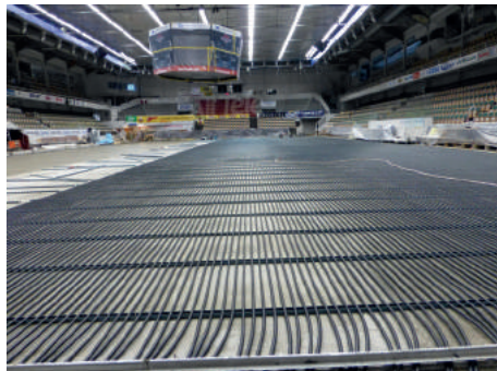
Rörförläggning i banbädd.
