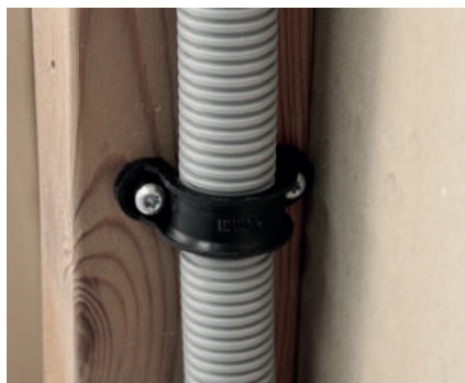
Installationsexempel med LK Plastklammer tomrör
