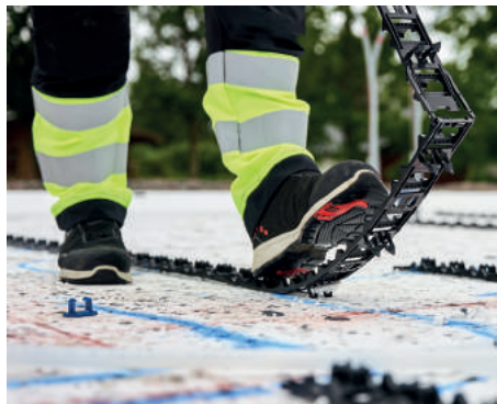
LK Golvvärmelist Combi 16/20 på EPS-isolering.
