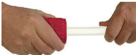
LK PE-X Universalrör gradas med rörfräs.
