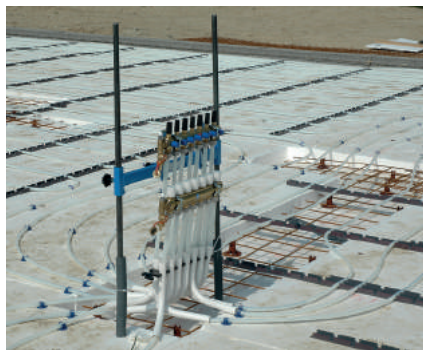
Installationsexempel med LK Fördelarstativ.
