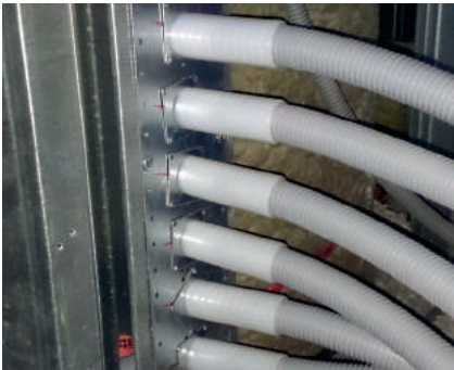
Installationsexempel med LK Genomföringshållare.
