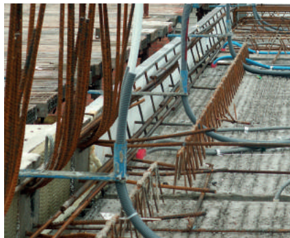
Installationsexempel med LK Rörfixtur UNI c/c 40.
