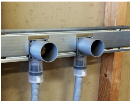
Installationsexempel med LK Väggskena Väggdosa UNI Push V3 c/c 160.
