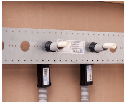
Installationsexempel med LK Väggskena 160 Mini.
