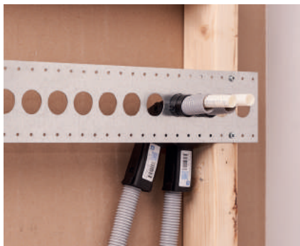
Installationsexempel med LK Väggskena 40.
