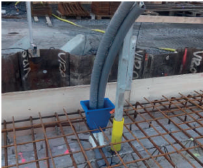
Installationsexempel med LK Radform
