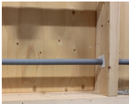
Installationsexempel med LK Fixeringsbricka 25.
