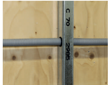
Installationsexempel med LK Tomrörsskydd 25.
