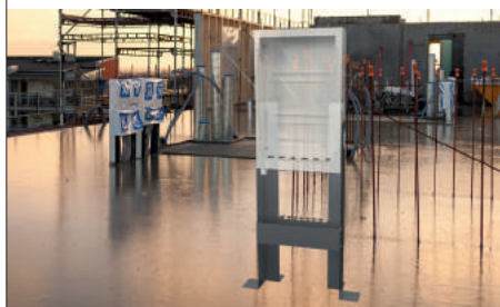
Installationsexempel med LK Flexiben och LK Flexiskydd. Finns i tre modeller anpassade för olika skåpsmodeller RSK 188 25 57 - 59.
