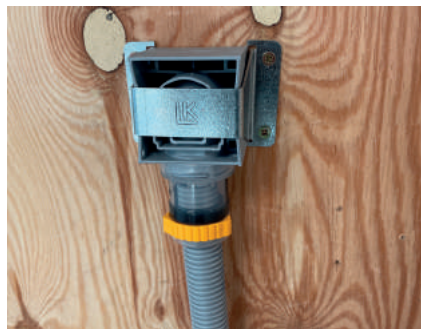
Installationsexempel med LK Fästbygel Väggsdosa UNI Push V3.
