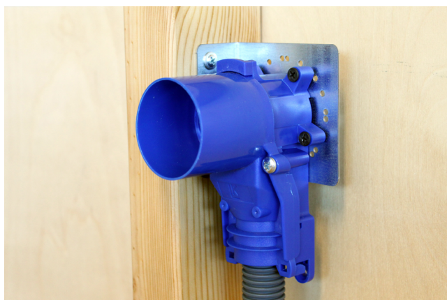
LK Väggdosfäste - 1 monterad på stående regel.
