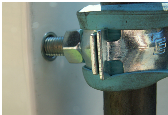
Närbild på infästning mot skåp.
