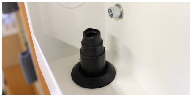
Montera rörgenomföringen i skåpet.
