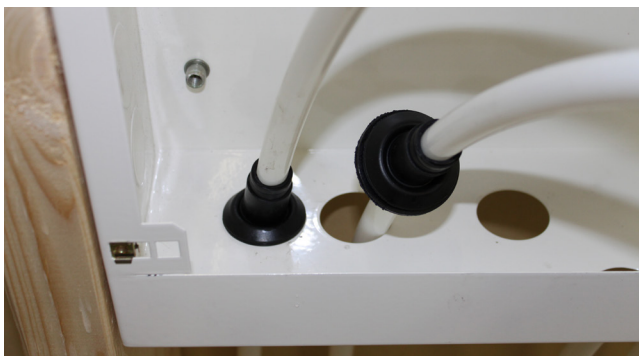
Montera rör genomföringarna.
