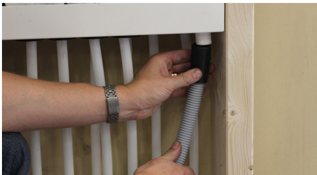
Montera gummimuffen
