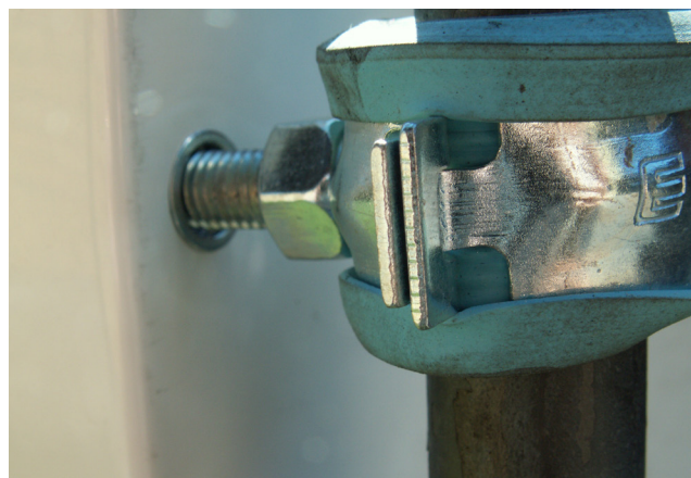
Närbild på infästning mot skåp
